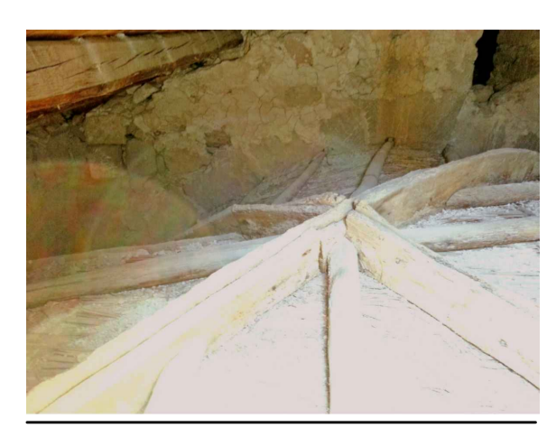
Foto 16 - Estradosso volta navata laterale
