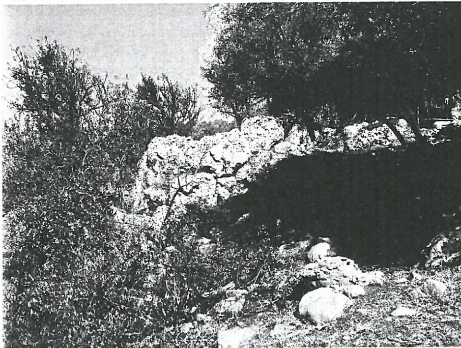
Fig. 35 - Punto di ripresa 35 dell'area Soprabanco
