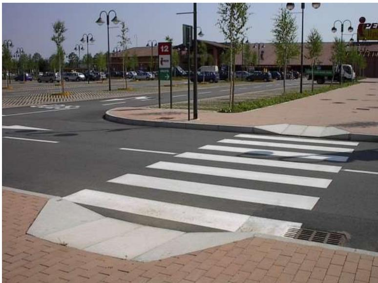
10 - Esempio di raccordo tra pavimentazione del marciapiede e della carreggiata
